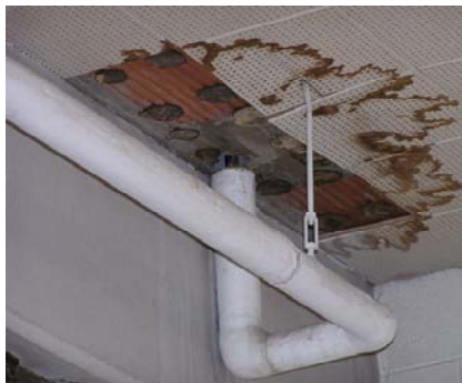
Salir la línea del vapor; atascó línea de flotación; bomba caduca de condensate de vapor (50 años de edad; vida útil normal = 25 años)
