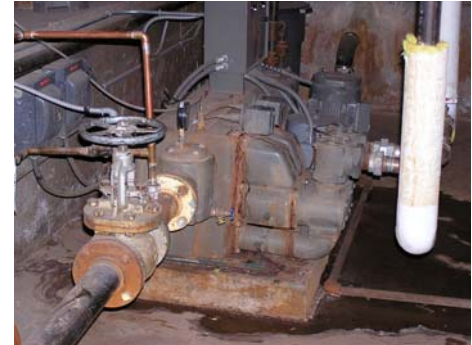
Salir la línea del vapor; atascó línea de flotación; bomba caduca de condensate de vapor (50 años de edad; vida útil normal = 25 años)
